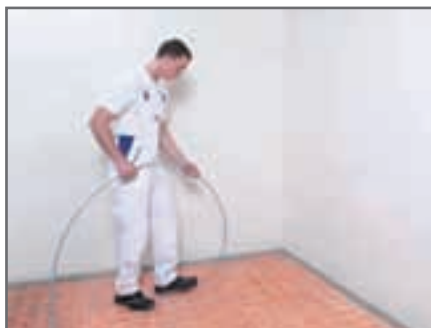
Einklicken des Heizrohres
